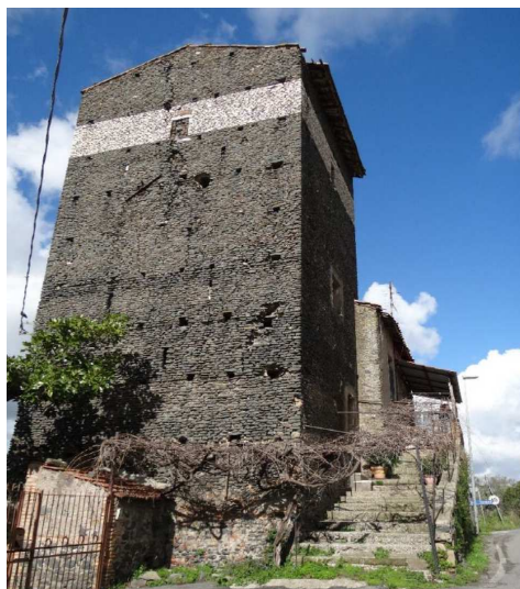
Fig. 2. Torre della Cancelleria (Autore).
