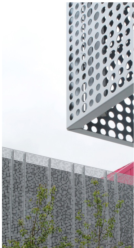
Detalle chapa metálica perforada
