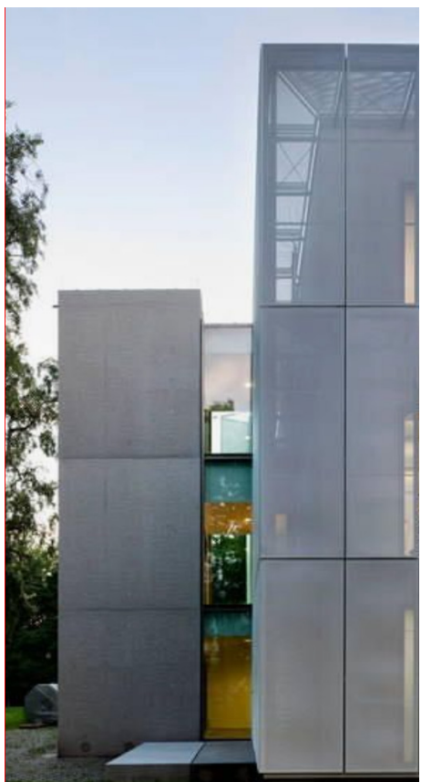
Visión chapa metálica perforada
