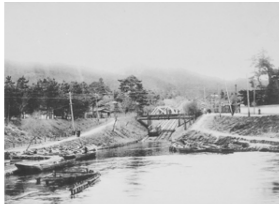
Fig. 758. Construcción del canal a la altura de Murin-an
