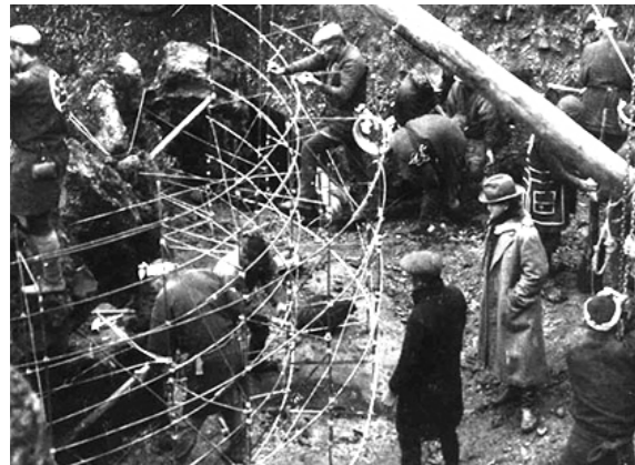
Fig. 611. Construcción de la colina artificial junto al estanque en Tsuji-ke
